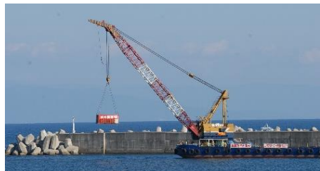
大規模津波防災総合訓練（航路啓開訓練）
