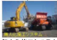
無人化施工システム
