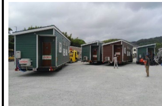
西日本豪雨における仮設住宅設置の様子
