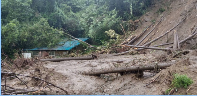
上水道水源地被災 (高原町)
