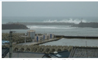
高波の進入や港内の攪乱状況
