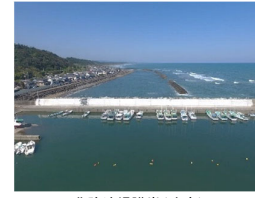
北防波堤護岸(改良)
