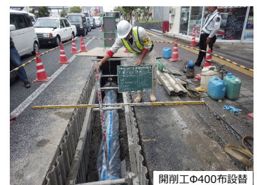
開削工Φ400布設替
