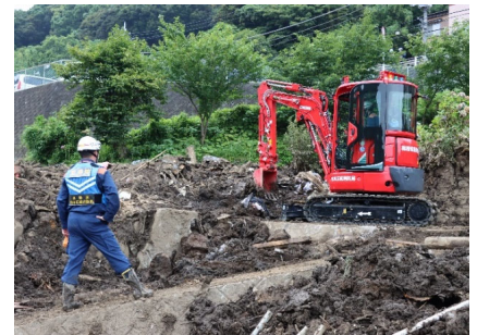
○重機で土砂排除【長野県大隊】
