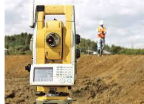
【トータルステーションの測量】
