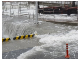
越波による浸水
