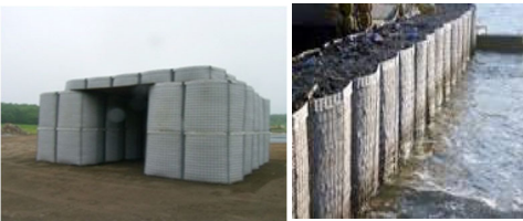
【簡易防護壁(箱型土嚢)】【河川氾濫時の塞き止めの様子】
