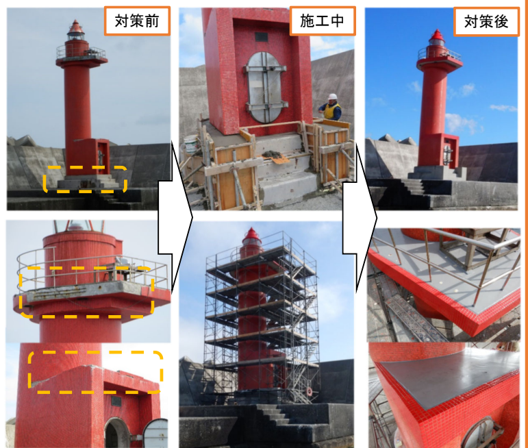
稚内港北副防波堤東灯台
