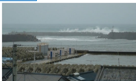
高波の進入や港内の攪乱状況
