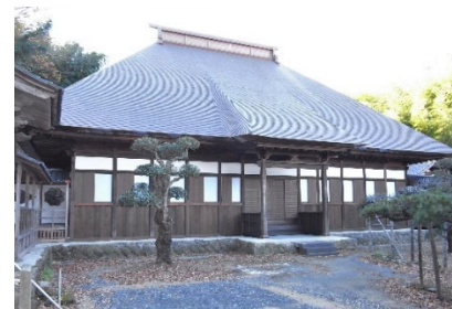
本堂外観(修理・補強後)
