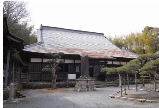
本堂外観(修理前)
