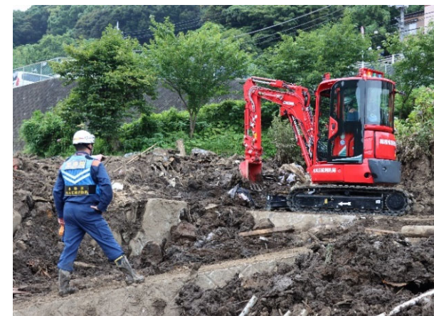
○重機で土砂排除【長野県大隊】
