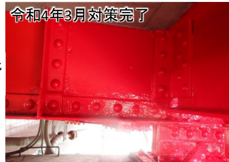
腐食除去・再塗装
