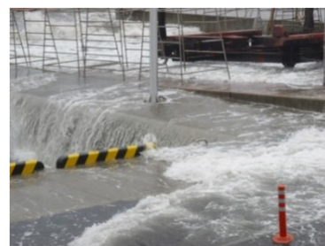
越波による浸水
