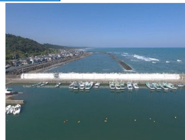
北防波堤護岸(改良)
