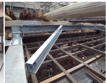
小屋内に組み込まれた鉄骨フレーム
