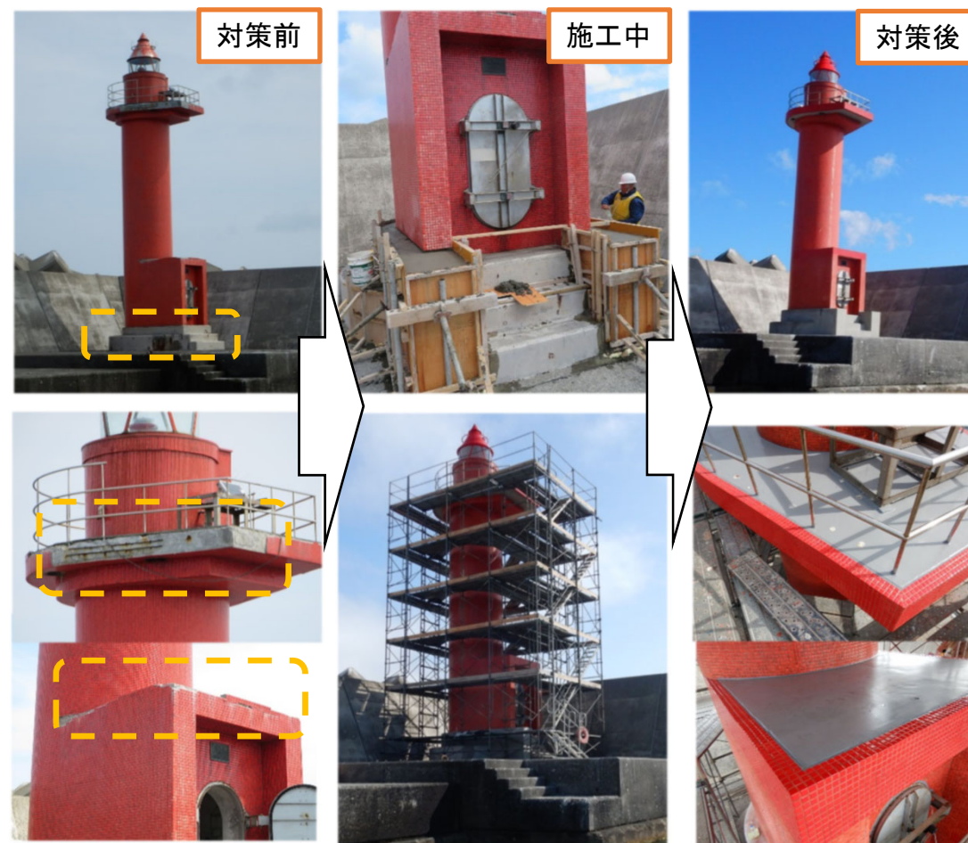
稚内港北副防波堤東灯台
