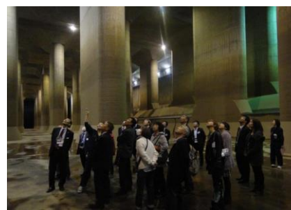
▲首都圏外郭放水路視察 (埼玉県春日部市)
