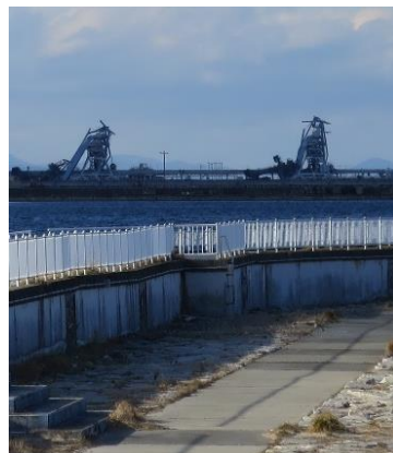
▲港・クレーン倒壊
