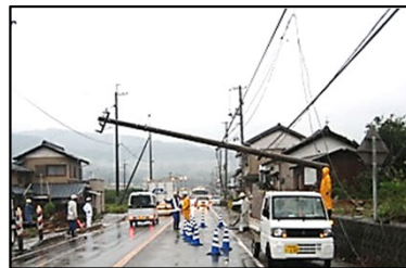
【電柱が道路を閉塞した事例】
