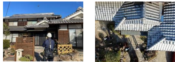
「屋根見守り隊」による定期点検
