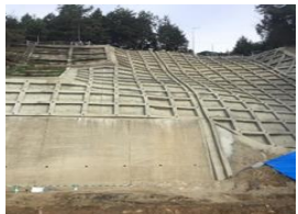
法面防護工による土砂流入防止対策
