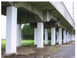
鋼板巻きによる耐震対策
