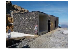
活動火山対策避難施設(退避壕、退避舎)
