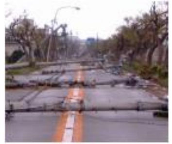
電柱の倒壊による道路閉塞
