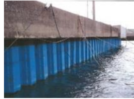
岸壁、鋼製矢板の 腐食対策
