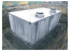
耐震性貯水槽
