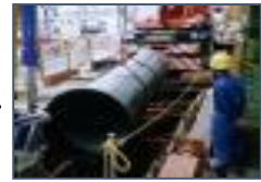
基幹管路の耐震化
