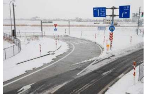
消融雪施設の整備
