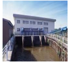
排水機場の整備
