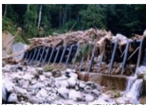
治山ダムによる流木の流出等の抑制 流木捕捉式治山ダムの設置
