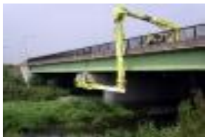
橋梁点検車を使った 橋梁点検
