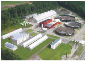
バイオガス発電・熱利用
