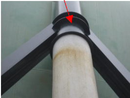
球形貯槽を支える脚部の補強対策
