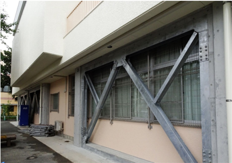
写真: 耐震補強工事後
