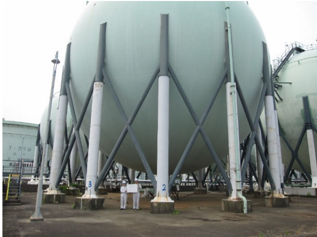
球形貯槽(耐震補強前)
