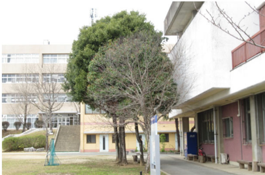
写真: 耐震補強工事前
