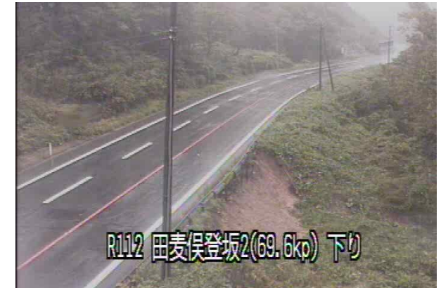
＜CCTVカメラによる遠隔監視の充実＞
