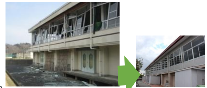
地震によりガラスが落下
