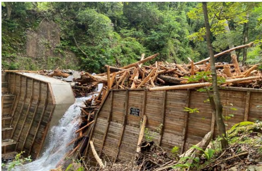
流木捕捉式治山ダムが流木及び土砂を捕捉した例 (熊本県球磨村)
