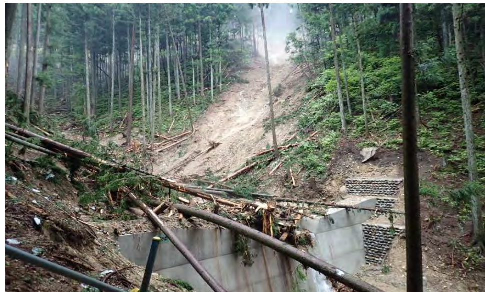
治山ダムが崩壊地から流れ出た土砂や倒木の流出を防止した例 (岐阜県下呂市)
