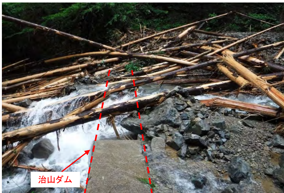
治山ダムが溪流の勾配を緩やかにしていたため流木流出を防止した例 (福岡県八女市)
