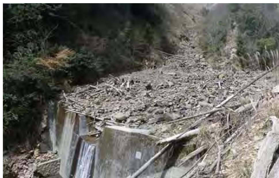
治山ダムが土石流の勢いを軽減した例 (大分県日田市)
