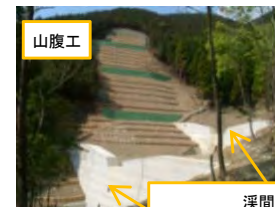
山腹工 溪間工 (治山ダムによる山脚の固定)
