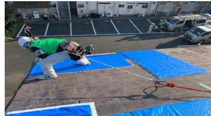
職人によるブルーシート展張の様子
