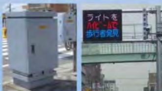
信号機電源付加装置 交通情報板
