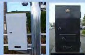
新設した信号機電源付加装置 更新された信号制御機
