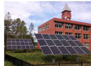
避難所に設置した太陽光発電
