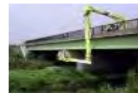
橋梁点検車を使った 橋梁点検
