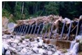
流木捕捉式治山ダムの設置
