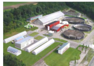
バイオガス発電・熱利用
