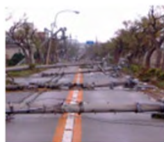
電柱の倒壊による道路閉塞
