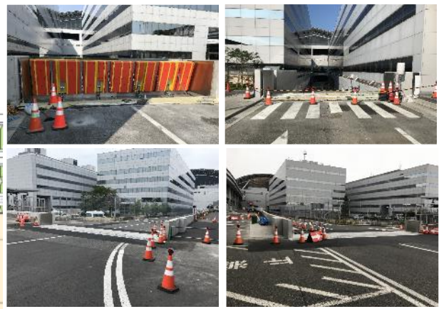
T1(南北) 止水板の設置 (6/26完了)
