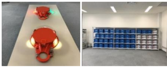
非常用滑走路灯の導入 (6/12完了)
