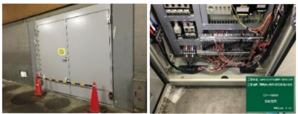
T1地下水密扉の設置・T1制御盤の嵩上げ等 (6/26完了) (6/11完了※止水処理)
