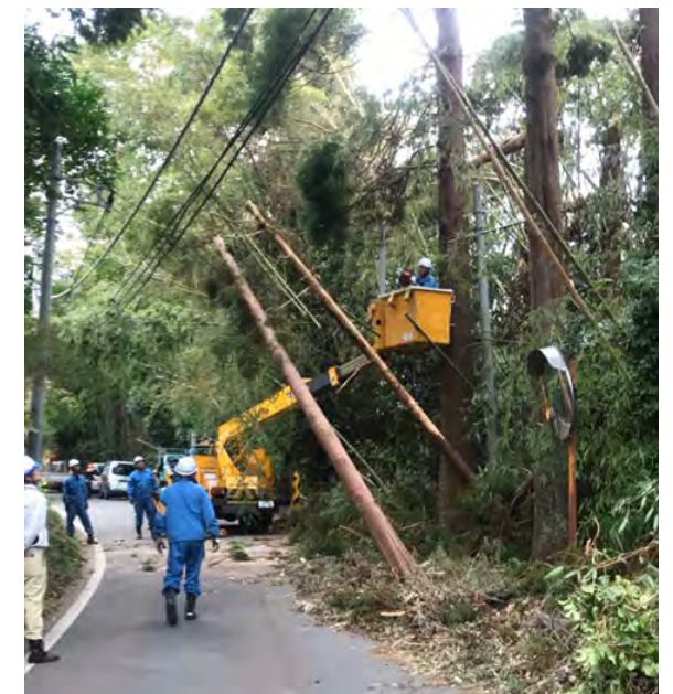
+ 高所作業車、技術者
