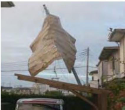
＜飛来物による電柱倒壊（東金市）＞
