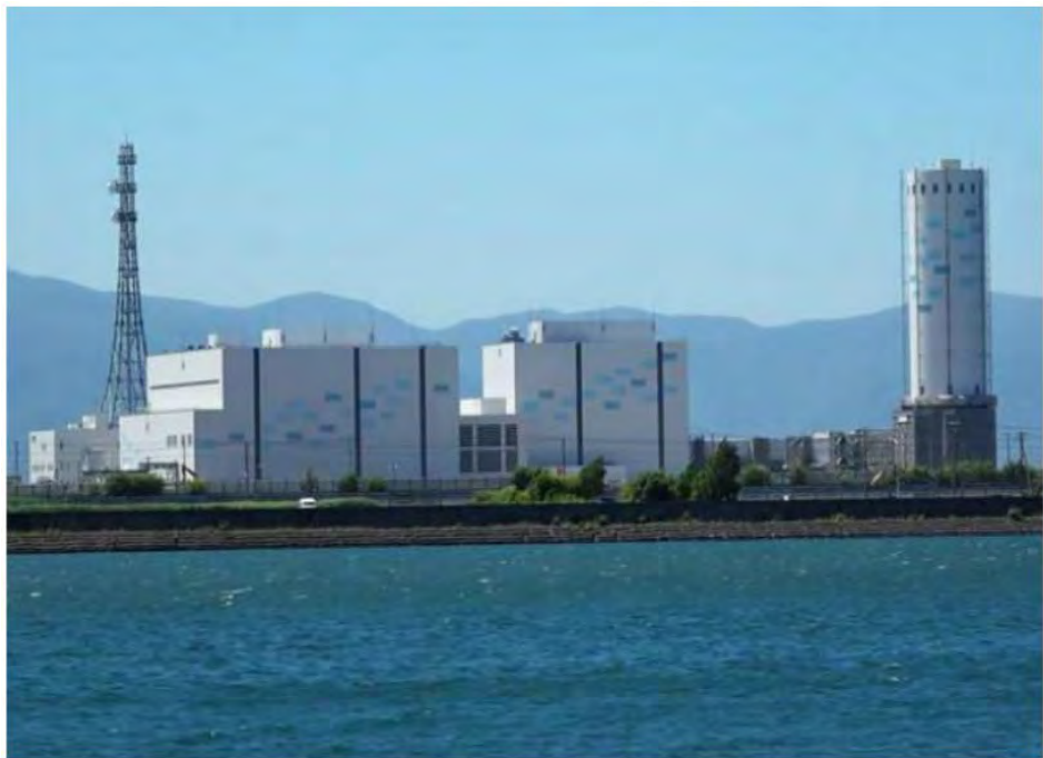
石狩湾新港発電所全景（北海道電力(株)ウェブページより）
