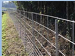
侵入防止柵の設置
