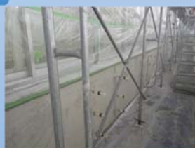
外壁改修工事の様子
