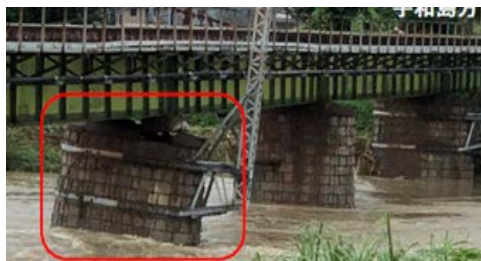
平成30年7月豪雨により傾斜した橋脚
