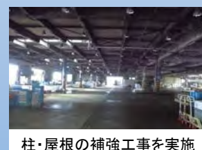
柱・屋根の補強工事を実施
