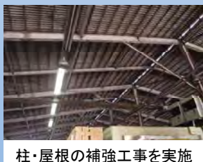
柱・屋根の補強工事を実施
