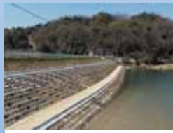
耐震化整備（対策後）
