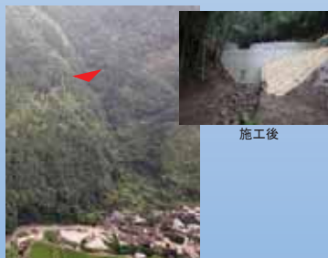
保全対象と施工箇所
