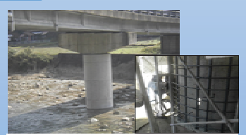
下部工の耐震化（橋脚の補強）
