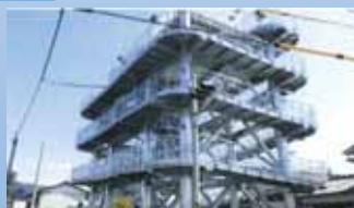
津波避難タワー
