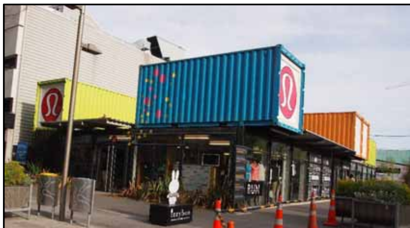
(NZクライストチャーチ) 仮設商店街Re:START (リスタート)
