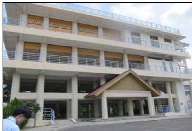
(インドネシア アチェ) 津波避難タワー
