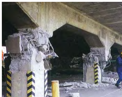
高架橋柱の被害状況
