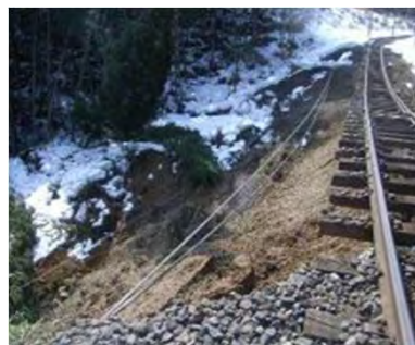
盛土の被害状況
