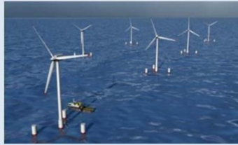
浮体式洋上風力発電
