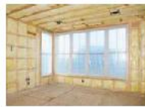
【天井・外壁の断熱改修】
