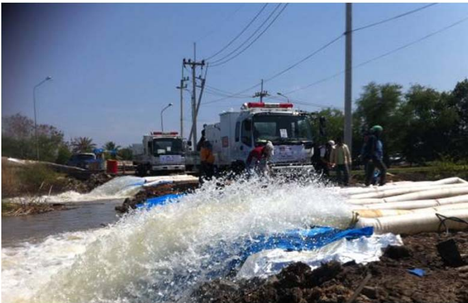
排水ポンプ車稼働状況（11月19日作業開始）
