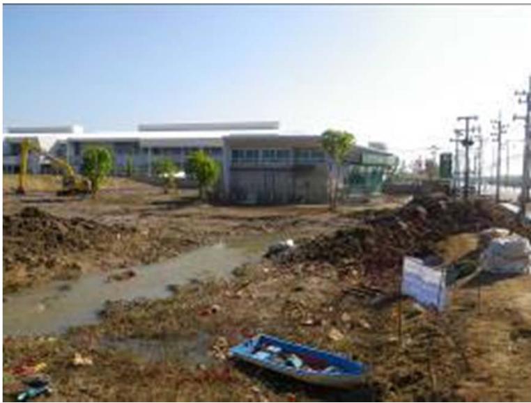
排水後の状況（11月27日作業完了）
