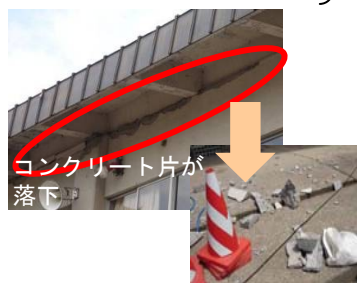
地震による非構造部材の落下の危険性
