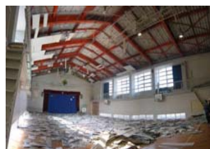
地震による非構造部材の落下の危険性
