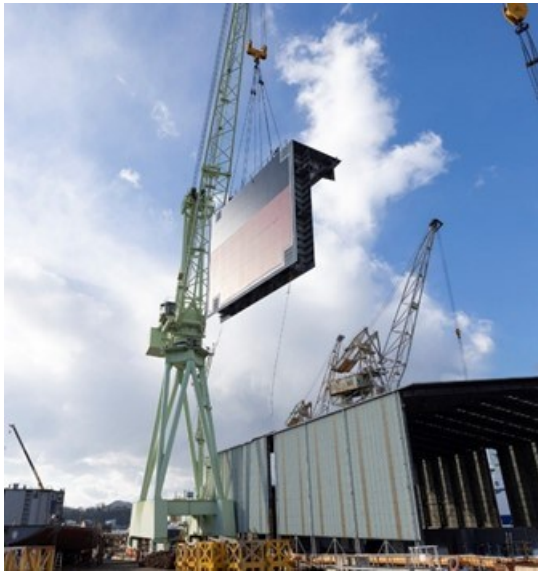
ジブクレーン(吊能力が低い)
