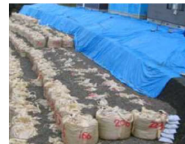
応急対策 (土留工)
