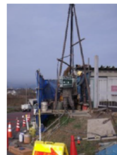
詳細調査 (ボーリング)
