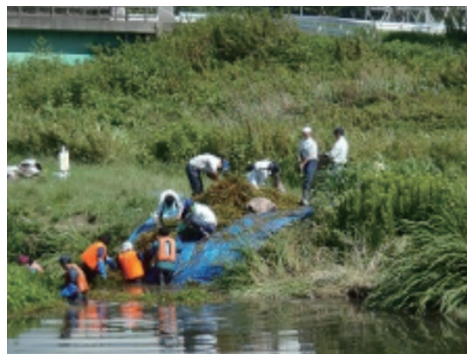
陸揚げ作業の様子
