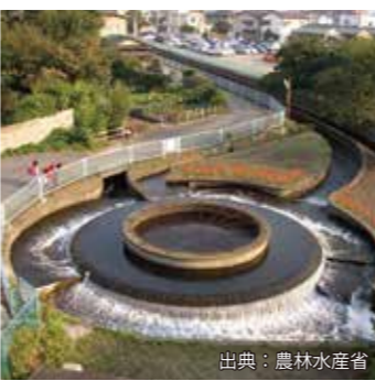
出典：農林水産省 「円筒分水」は農地などで貴重な水を平等に自動で分け合う装置
