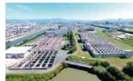
下水処理場 市之井手浄水場(愛媛県)
