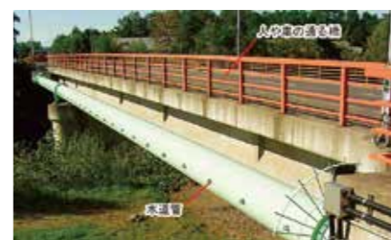
上水道 水道管(北海道)
