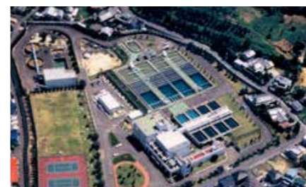
浄水場 市之井手浄水場(愛媛県)
