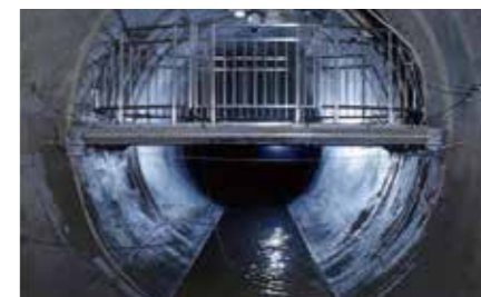
下水道 小平市ふれあい下水道館
