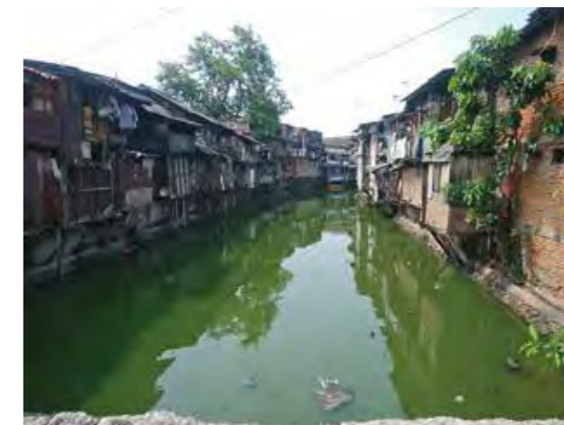
ジャカルタ特別州の下水道が未整備の川
