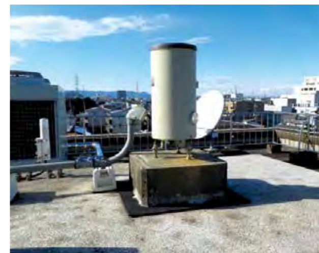
雨量観測施設
