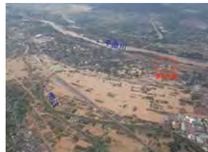
令和元年東日本台風（信濃川水系千曲川）
