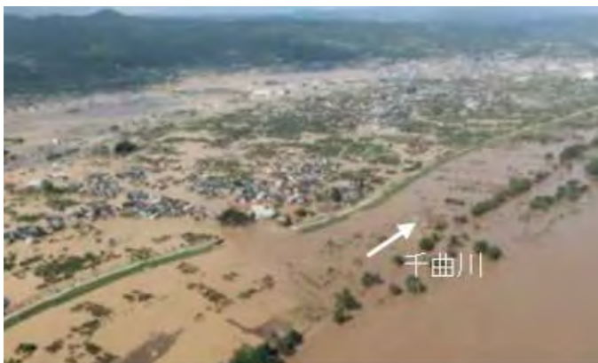
外水氾濫の様子：千曲川の破堤による浸水状況
