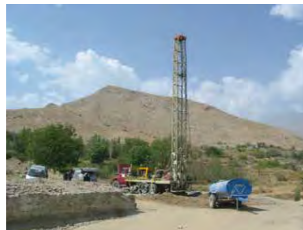
アフガニスタン パルヴァーン州に井戸を建設し、ハンドポンプで地元住民へ水を供給する予定の井戸を掘る様子
