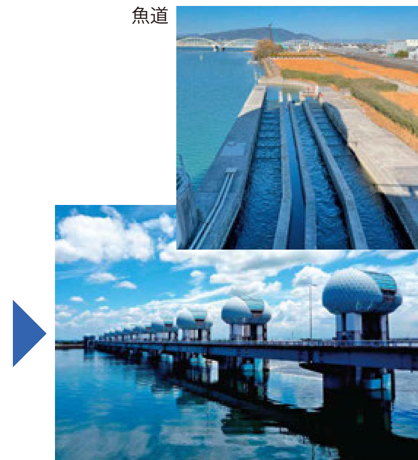
取水設備（堰） 長良川河口堰（三重県）
