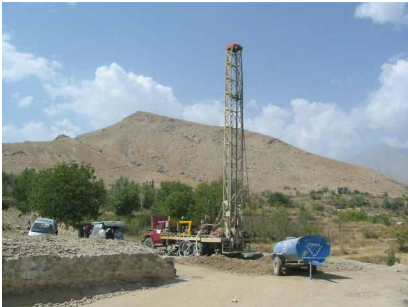
アフガニスタン バルヴァーン州に井戸を建設し、ハンドポンプで地元住民へ水を供給する予定の井戸を掘る様子
