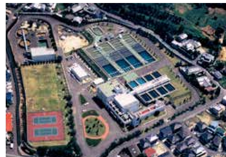
浄水場 市之井浄水場（愛媛県）
