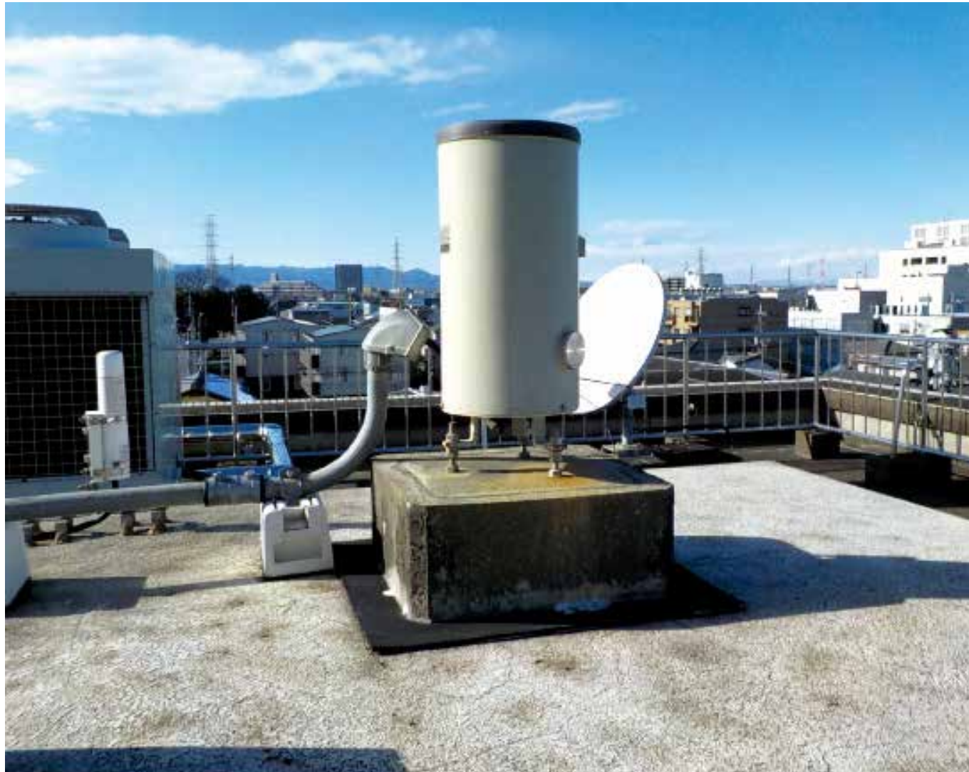
雨量観測施設
