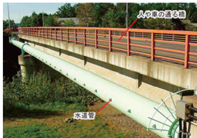
上水道 水管橋（北海道）
