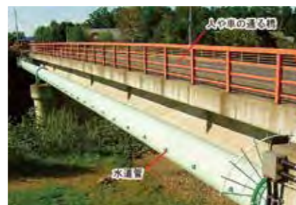
上水道 水管橋 (北海道)
