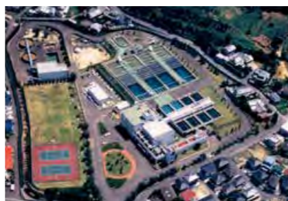
浄水場 市之井浄水場 (愛媛県)
