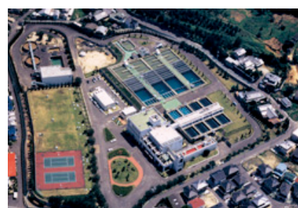
浄水場 市之井浄水場 (愛媛県)
