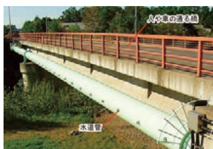
上水道 水管橋 (北海道)
