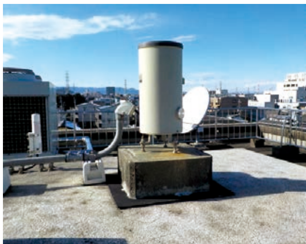
雨量観測施設
