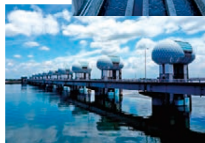
取水設備(堰) 長良川河口堰(三重県)
