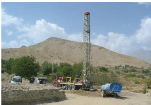
アフガニスタン バルヴァーン州に井戸を建設し、ハンドポンプで地元住民へ水を供給する予定の井戸を掘る様子
