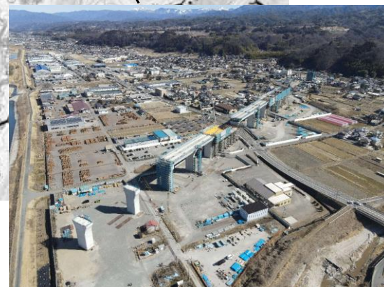
阿島北高架橋
