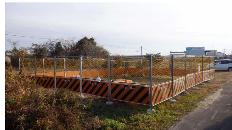
令和5年12月6日（水）ボーリング調査開始 (三重県 JR関西本線井田川駅周辺 JR東海提供)
