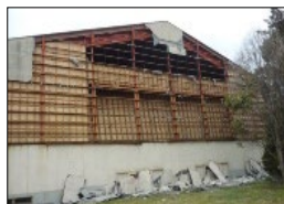
外壁の全面的な脱落事例
