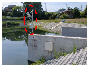
水位計等遠隔監視機器の設置
