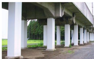
鋼板巻きによる高架橋の耐震補強
