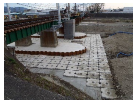
鉄道橋りょうの流失・傾斜対策
