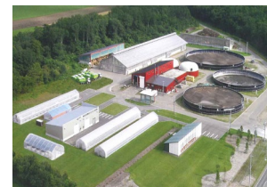
バイオガス発電・熱利用
