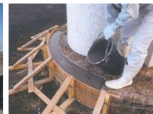
▲亀裂補修(環境遮断)
