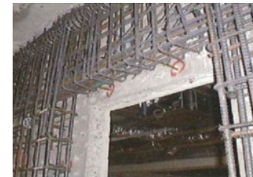
下水処理場の耐震化
