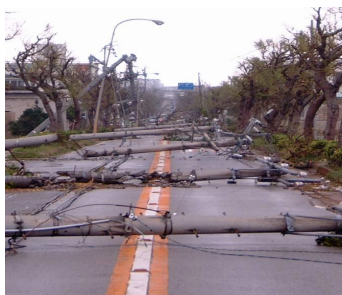
電柱の倒壊による道路閉塞
