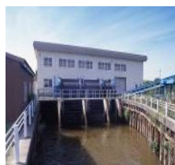
排水機場の整備
