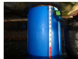
鋼管杭の被覆防食の更新
