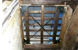
構造用合板補強（床・壁の内部）
