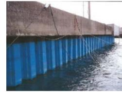
岸壁、鋼製矢板の腐食対策
