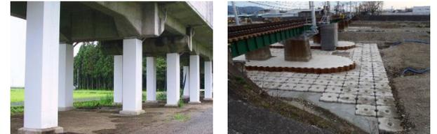
鋼板巻きによる高架橋の耐震補強 鉄道橋りょうの流失・傾斜対策
