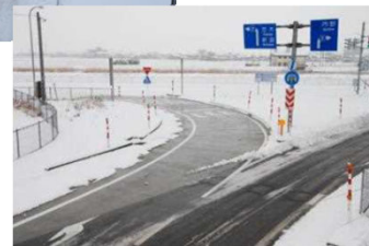
消融雪施設の整備
