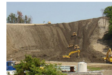
盛土撤去工事のイメージ
