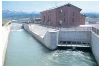
農業用水路を活用した小水力発電施設
