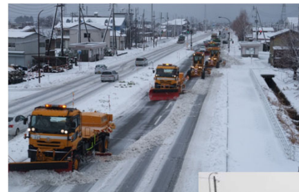
除雪機械の整備
