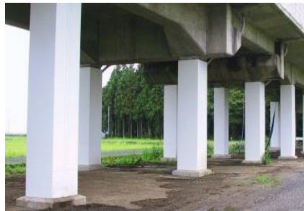
鋼板巻きによる高架橋の耐震対策
