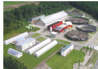
バイオガス発電・熱利用
