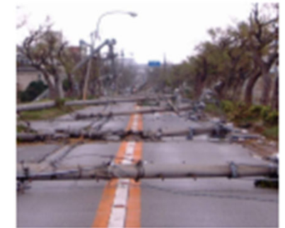
電柱の倒壊による道路閉塞
