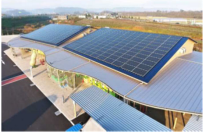
避難施設に設置した太陽光発電設備
