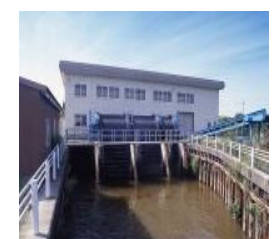
排水機場の整備
