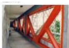
鉄骨ブレースによる壁の補強
