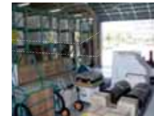
備蓄倉庫(地域防災拠点施設)
