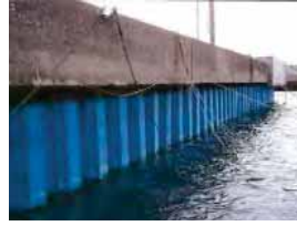
岸壁、鋼製矢板の 腐食対策
