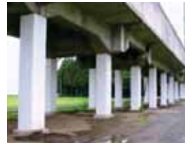
鋼板巻きによる耐震対策
