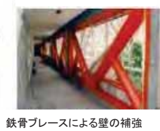
鉄骨ブレースによる壁の補強
