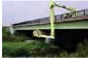
橋梁点検車を使った 橋梁点検
