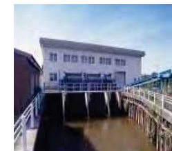
排水機場の整備
