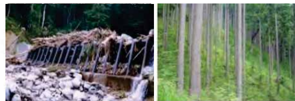
治山ダムによる流木の流出等の抑制 流木捕捉式治山ダムの設置
