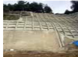
法面防護工による土砂流入防止対策
