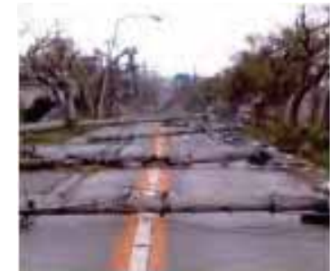
電柱の倒壊による道路閉塞
