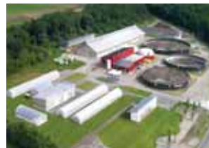
バイオガス発電・熱利用
