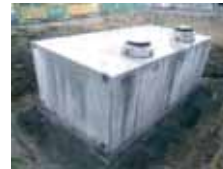
耐震性貯水槽
