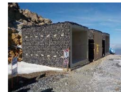
活動火山対策避難施設(退避壕、退避舎)
