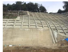
法面防護工による土砂流入防止対策
