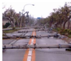
電柱の倒壊による道路閉塞
