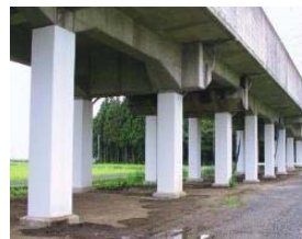
鋼板巻きによる耐震対策
