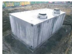
耐震性貯水槽
