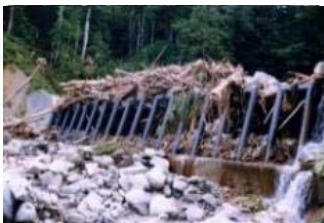
流木捕捉式治山ダムの設置
