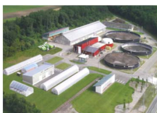
バイオガス発電・熱利用
