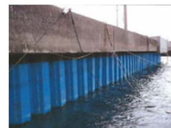
岸壁・鋼製矢板の腐食対策
