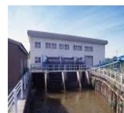
排水機場の整備
