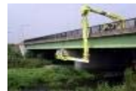
橋梁点検車を使った橋梁点検
