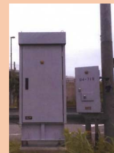
信号機電源 付加装置
