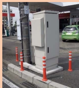
信号機電源 付加装置
