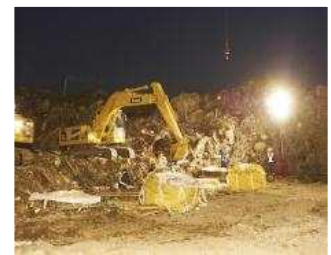
2011.12 夜間作業の様子 (宮城県石巻市)
