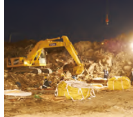
2011.12 夜間作業の様子 (宮城県石巻市)
