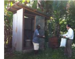
【トイレ調査状況】
