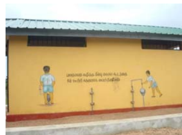
【建設された男女別トイレ】
