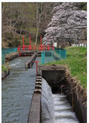
世界かんがい施設遺産 (一関市照井堰用水)
