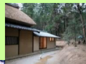
保存管理施設の設置
