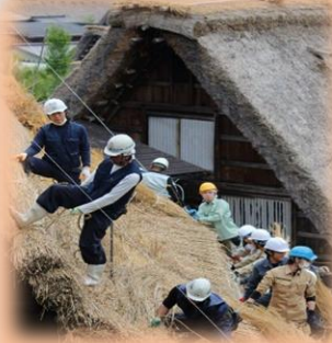
<岐阜県 白川村荻町> 修理事業の様子
