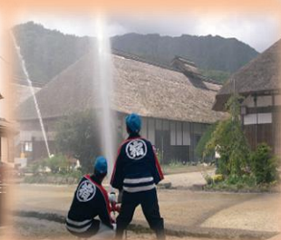
<福島県 下郷町大内宿> 防災事業で整備した放水銃
